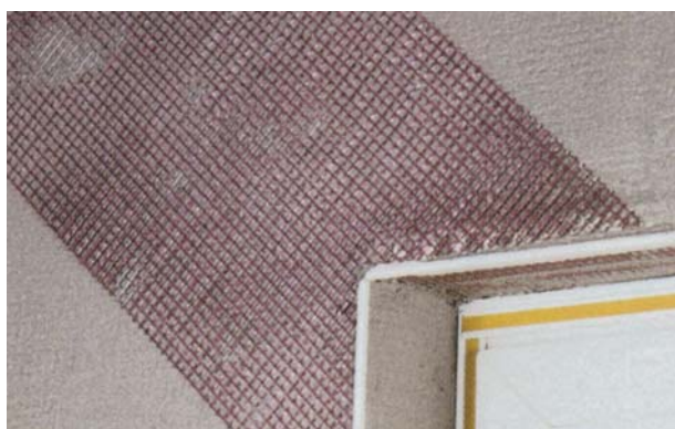
Bild 7: Armierungspfeil an Öffnungsecken
