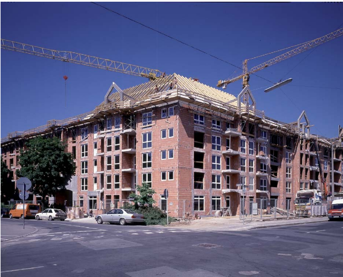
Bild 2: Homogenes Ziegelmauerwerk
