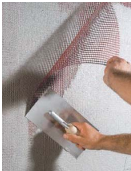
Bild 8: Armierungsputz mit Gewebeeinlage
