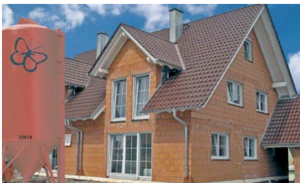
Bild 4: Homogener Putzgrund
