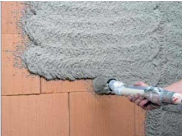
Bild 14: Auftrag des Unterputzes auf Planziegelmauerwerk
