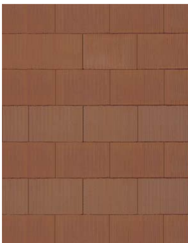
Bild 9: normgerechtes Überbindemaß
