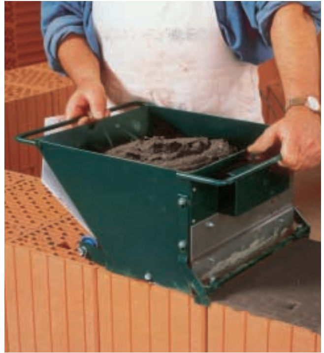
Abb. 8: Deckelnder Auftrag von Dünnbettmörtel
