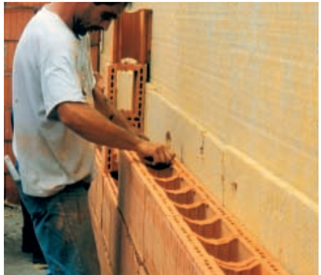
Abb. 16: zweischalige Haustrennwand mit dem unipor-Schalungsziegel
