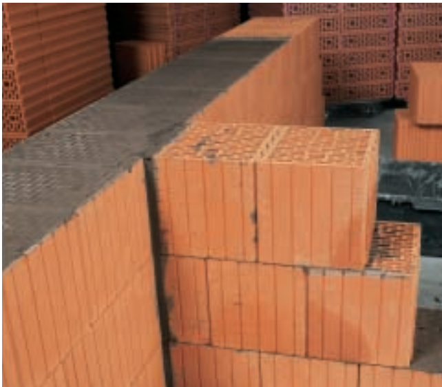
Abb. 14: PlanZiegel-Mauerwerk für Außen- und Innenwände, druck- und zugfest mit Flachstahlanker verbunden
