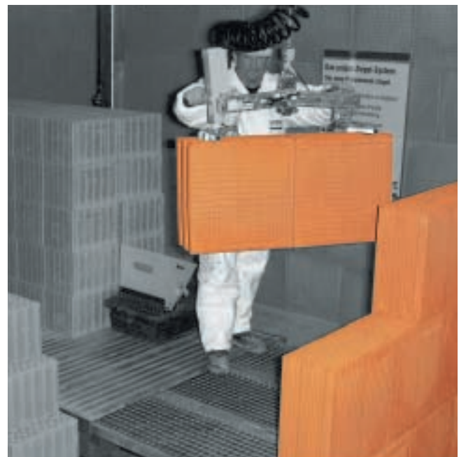
Abb. 12: Verlegung von Planelementen mit Verlegehilfe
