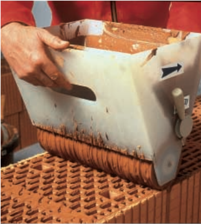
Abb. 7: Verarbeitung von Dünnbettmörtel mit der Auftragsrolle
